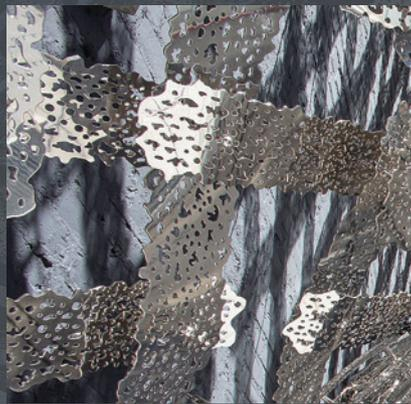
複雑な構造とエンジニアリングを駆使した「葉」のリボンは、11ゲージ(3mm)の316L合金 (UNSS31603) ステンレス鋼からレーザーカットされ、裏面は#4無方向性仕上げ、表面は#7鏡面仕上げで研磨されています。
